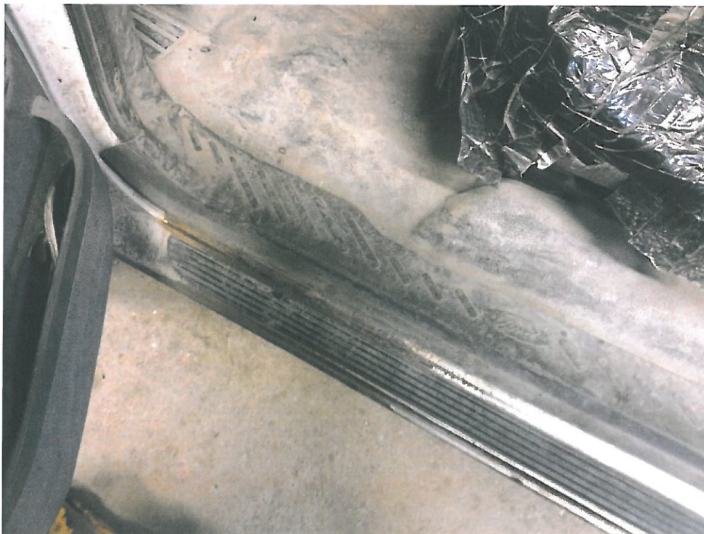
Door sill rusting
